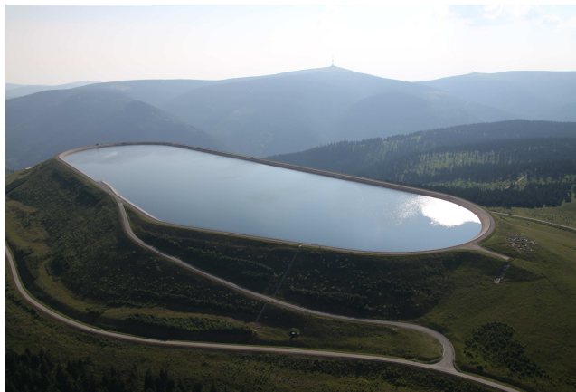
Obrázek 7 - Horní nádrž přečerpávací elektrárny Dlouhé Stráně [8]
