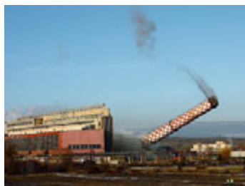
❑ Demolice téměř dvousetmetrového komína v Elektrárně Tušimice I – staré elektrárny ustupují novým ❑ Počítačová simulace nového 660MW bloku Elektrárny Ledvice – vlevo stávající stav, vpravo nový stav
